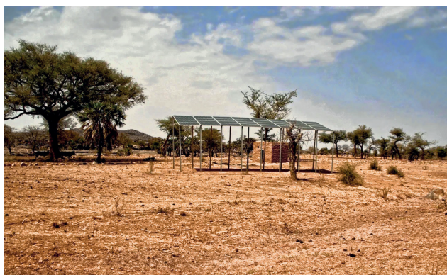
Ил. 2. Солнечные панели у деревни Тинтан. От них работает насос, качающий воду из колодца на водопое для скота
